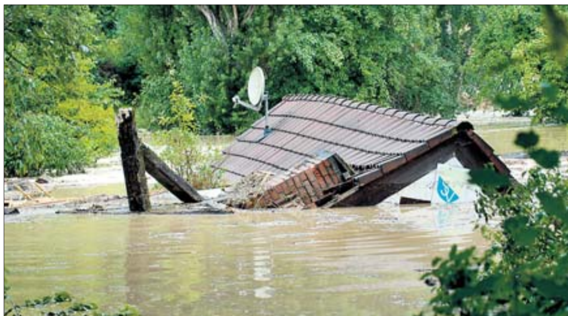
Versinkt in schlammiger Brühe: Das Sportheim des SV Groß Ellershausen wird zerstört.
